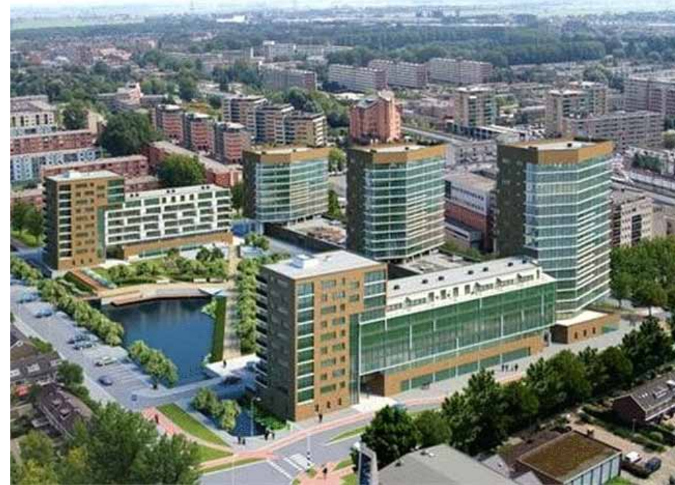
Hoven 1; De woontorens aan de Fluiterlaan hebben een hoogte van 16, 13 en 10 lagen
