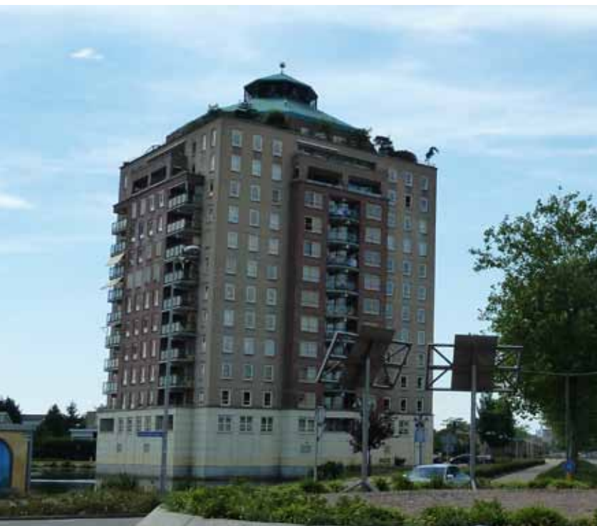
Woontoren 's Gravenland 15 bouwlagen
